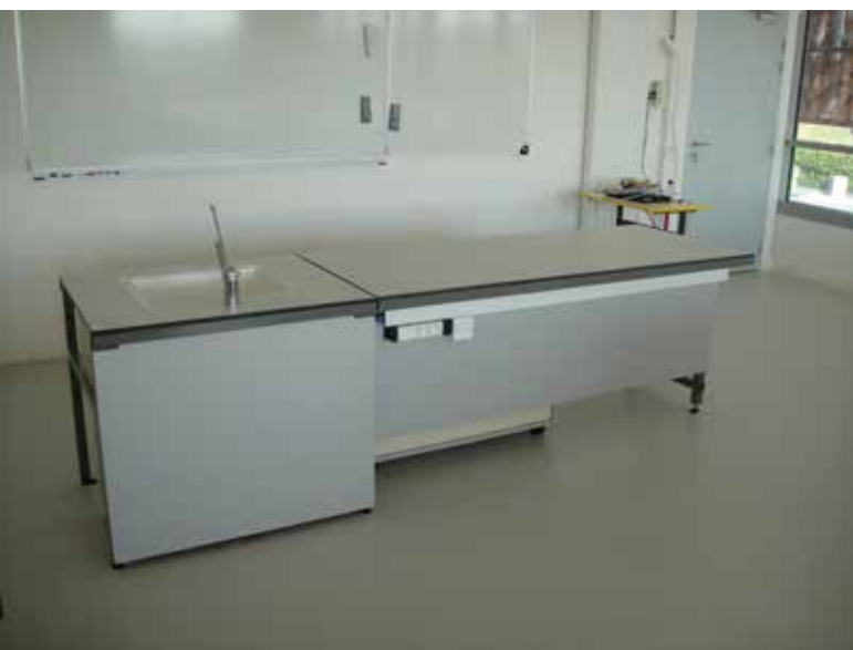
Poste PMR avec plan de travail réglable en hauteur par manivelle, et plot technique adapté au passage d'un fauteuil roulant.
