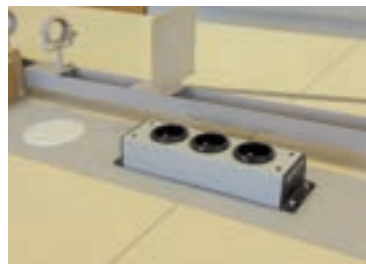
Console Inter-Tables destinée à la fixation des blocs prises en centre de paillasses ou de combinaisons de bahuts. Câblage sous console. (D)
